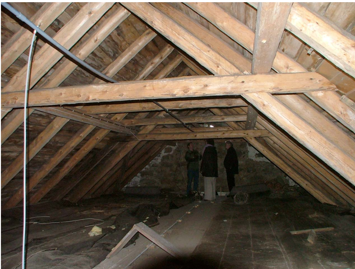
Takkonstruksjon fra 1864 i relativt god stand.
