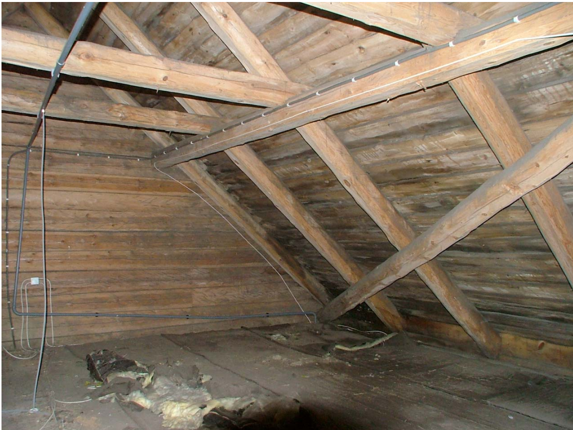
Loft. Tømret gavl i øst.
