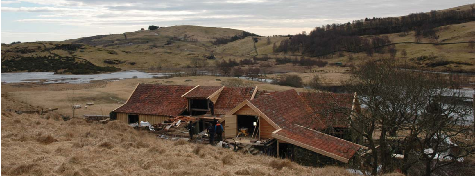
DRIFTSBYGNINGEN PÅ FØRSVOLL Foto: Nono Dimby
